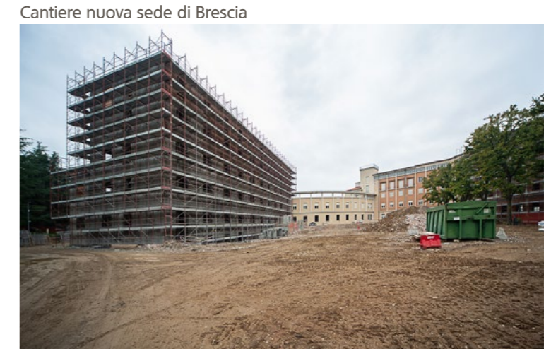
Cantiere nuova sede di Brescia
